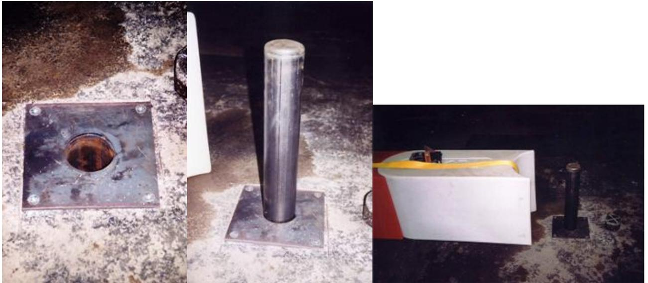
Le tube se compose de 2 parties, la partie femelle (qui rentrera dans le sol + une platine de fixation), et une partie male (qui rentrera dans la partie femelle). Cette pièce doit être fabriquée et installée par un professionnel.
